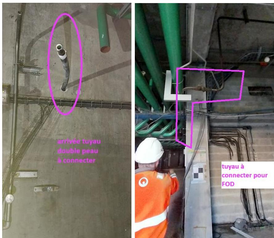
tuyau double peau à gauche de la porte d'entrée - tuyau à connecter
