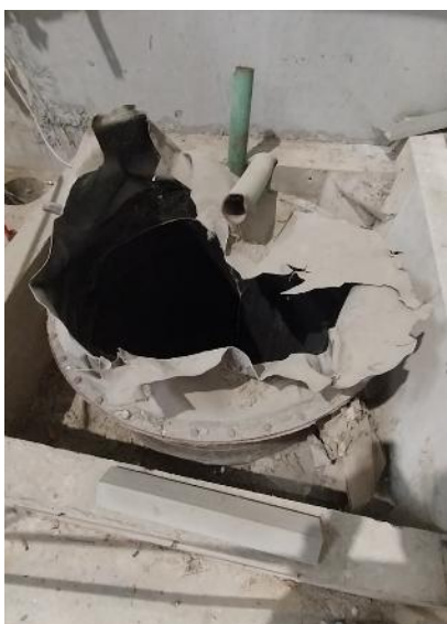
Sortie cheminée (gaine à reprendre et connecter à l'extérieur)
