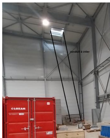
Sortie cheminée (gaine à reprendre et connecter à l'extérieur)
