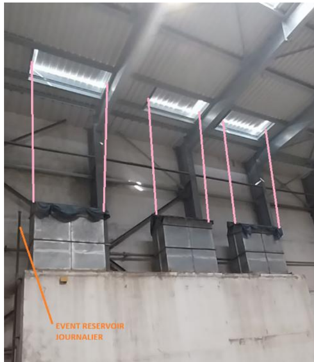
Anciennes entrées d'air à finaliser si réutilisation (non connectées en toiture à ce jour)
