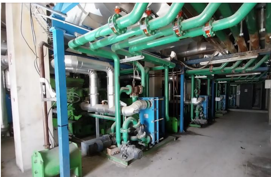
vue des 4 GE existants, avec échangeurs (bleu) et circuit refroidissement (vert)
